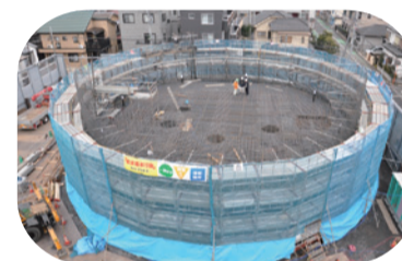
23年度に工事が始まり25年度に完了した北町地区雨水調整池
