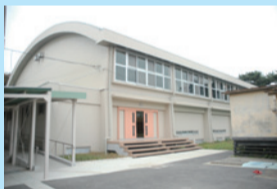
25年度末に耐震化と大規模改修が完了した一中体育館
